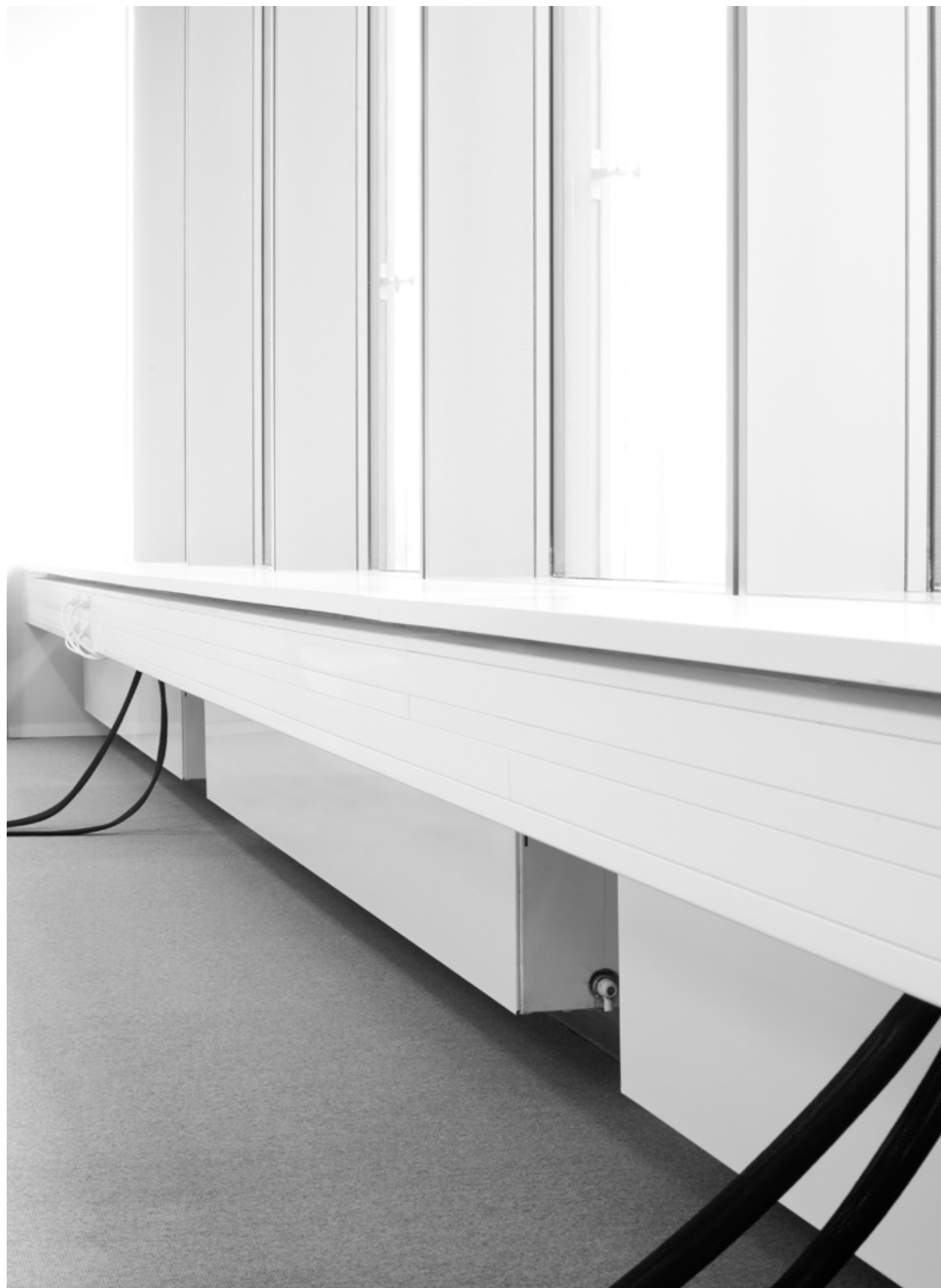
Installationskanaler i rene linjer og minimalistisk design. Rambøll Danmark, København.
