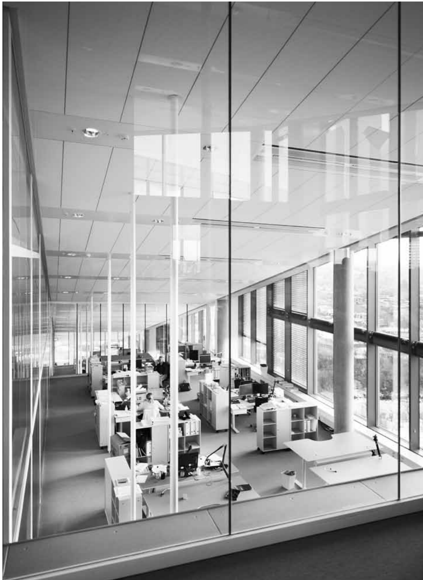
Duelco ClickSystems rumsøjler fører elegant kabler ned fra loftet. Se også side 10. Rambøll Danmark, København.
