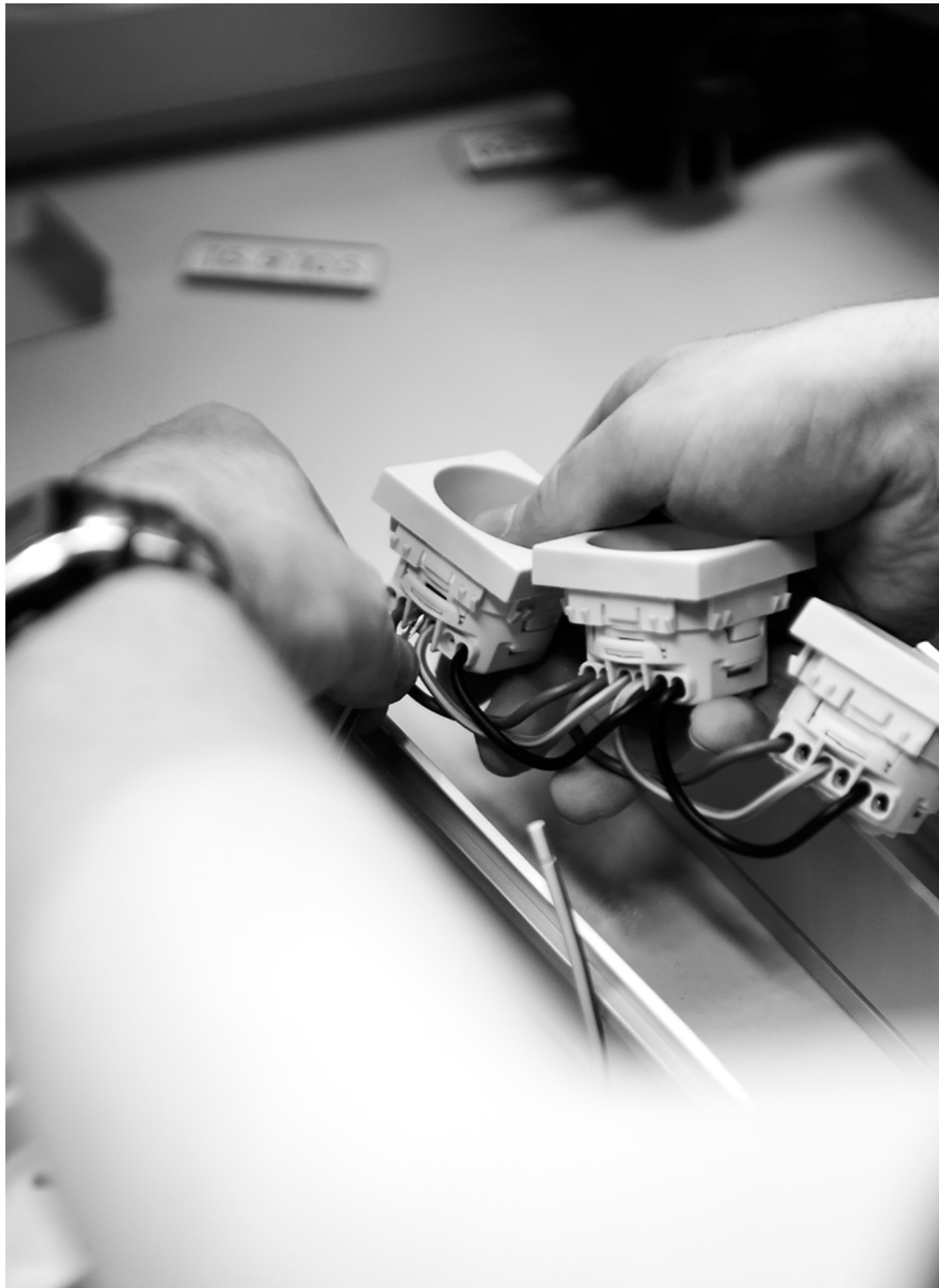
Duelco ClickSystem 45 mm-teknik monteres direkte i installationskanalen.
